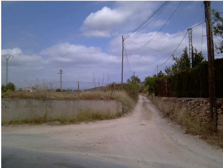
Caminos rurales, y conexiones con la red viaria municipal. Abundancia de postes telefónicos y de alumbrado.
